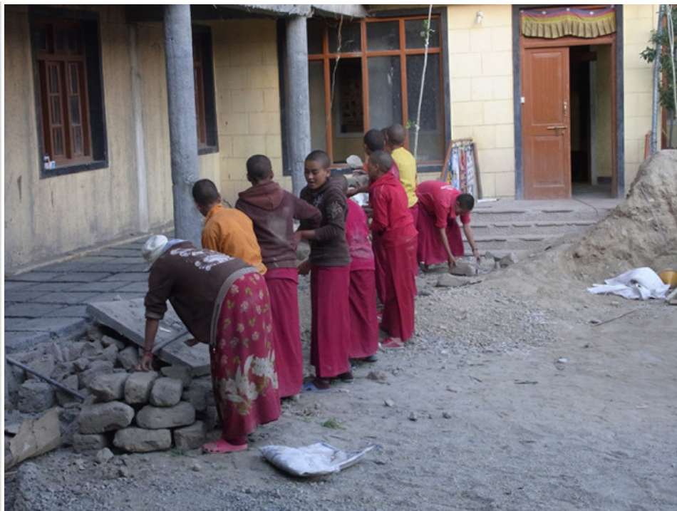
▲洪水で崩れた建物を皆で修復
