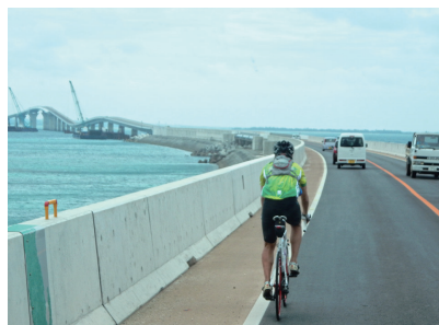
写真1 伊良部と宮古に架かった橋
